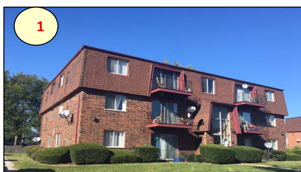
1 عمارة 12 شقة للبيع تنلي بارك 12 UNITS / TINLEY PARK. FULLY OCCUPIED CALL RIMA!
